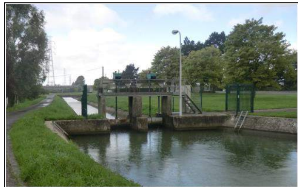
Figure 18 : Partiteur de Watten depuis l'amont (source : Antea Group)
